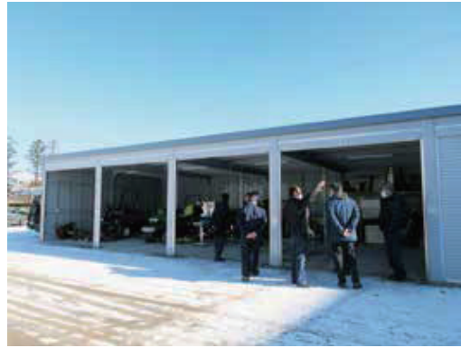
整備された管理倉庫
