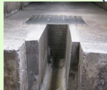
排水溝等からの侵入防止対策(鉄格子の設置)
