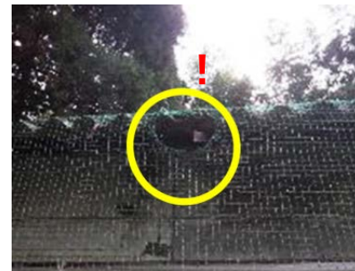
防鳥ネットの破れがないか
