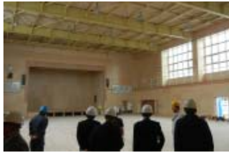
△建設中の小学校体育館
