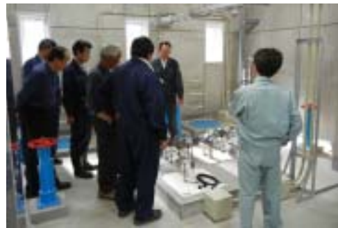
△南部地区浄水場(水上)
